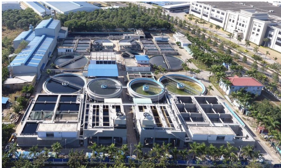
Hình 2. Hệ thống xử lý nước thải tập trung
